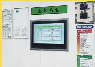
仮囲いにデジタルサイネージを設置し、工程表や騒音・振動計など現場の情報を開示することで、近隣住民とのトラブル防止の手段として活用できます。
