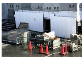
工事現場 / 資材置場
