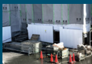
工事現場/資材置場
