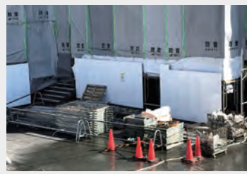
工事現場/資材置場
