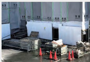
工事現場/資材置場
