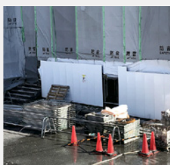
工事現場/資材置場
