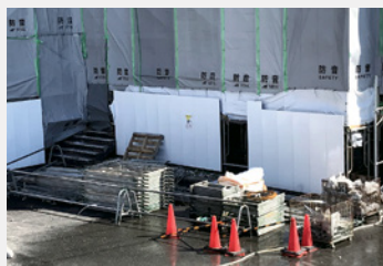
工事現場/資材置場
